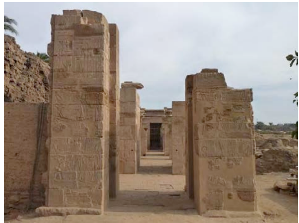
Figure 15. Porte A après réalisation des enduits de finition © Cnrs-Cfeetk /L. Pieri.
