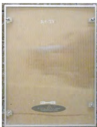
POSE DE POLYCARBOANTE ALVEOLAIRE AU REVERS
