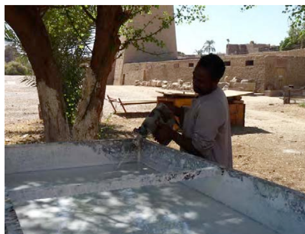
Figure 12. Fabrication de chaux en pâte sur site, malaxage © Cnrs-Cfeetk /L. Pieri.
