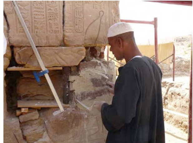
Figure 9. Ragréage en moellons de grès et chaux hydraulique importée ©Cnrs-Cfeetk /L. Pieri.
