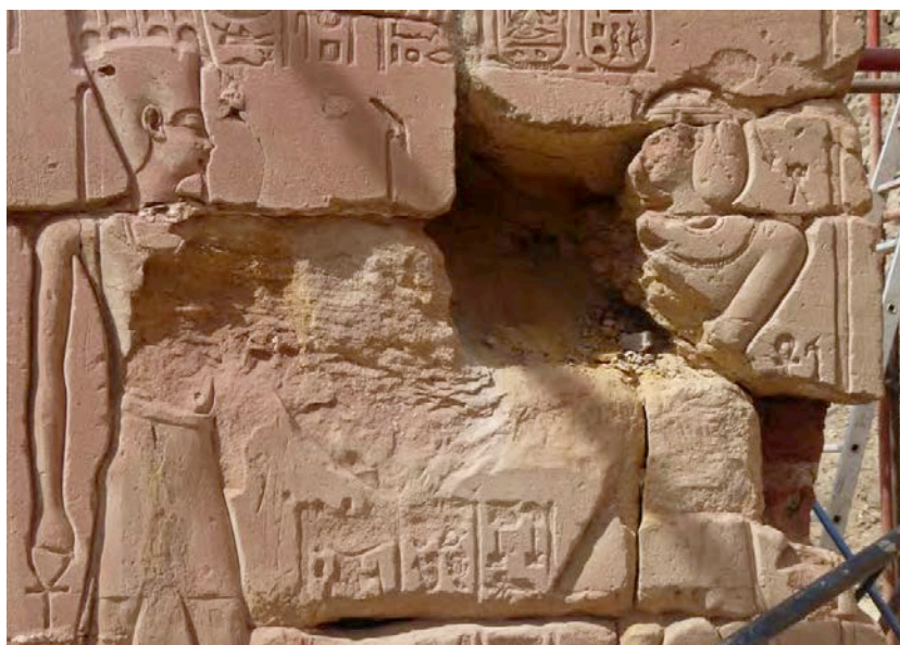
Figure 17. Désagrégation du grès sous les ragréages au ciment ©Cnrs-Cfeetk /L. Pieri
