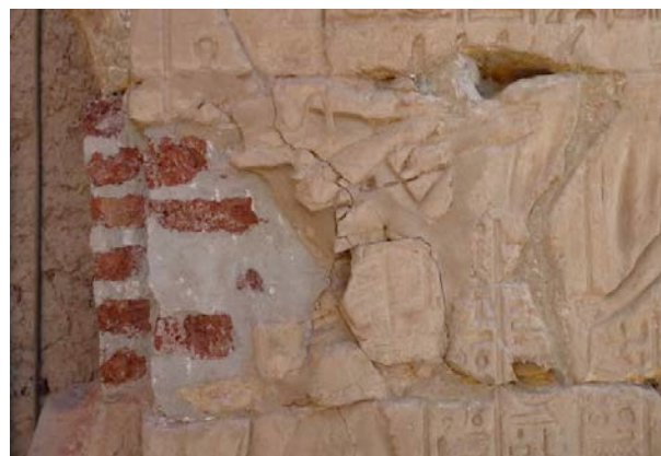
Figure 6. Ragréage par H. Chevrier vers 1930 en brique et ciment noir © Cnrs-Cfeetk /L. Pieri.
