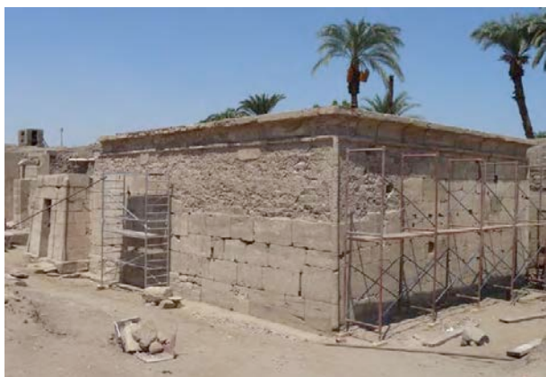
Figure 5. Réfection des murs par G. Legrain vers 1900 en grès de remploi © Cnrs-Cfeetk/L. Pieri.
