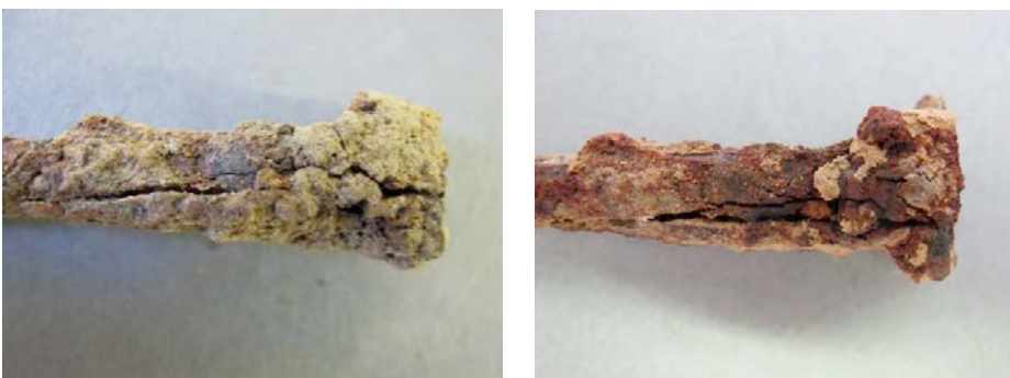
Figure 9: clous avant traitement
