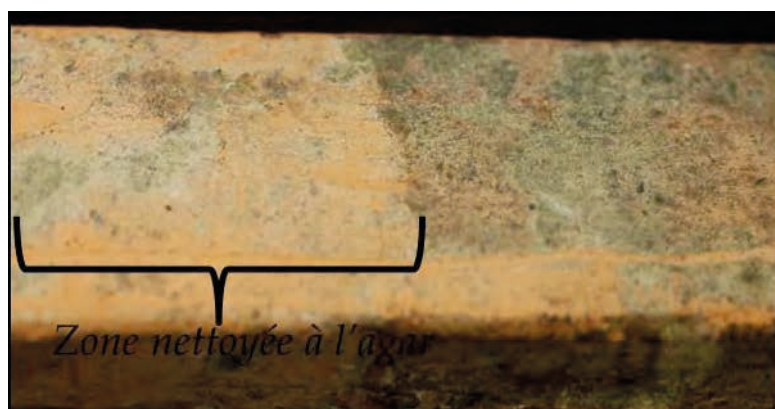
Fig. 6. Détail du bord de la cuve empoussiéré et encrassé : à gauche, après nettoyage au gel d'agar dans l'eau déminéralisée.
