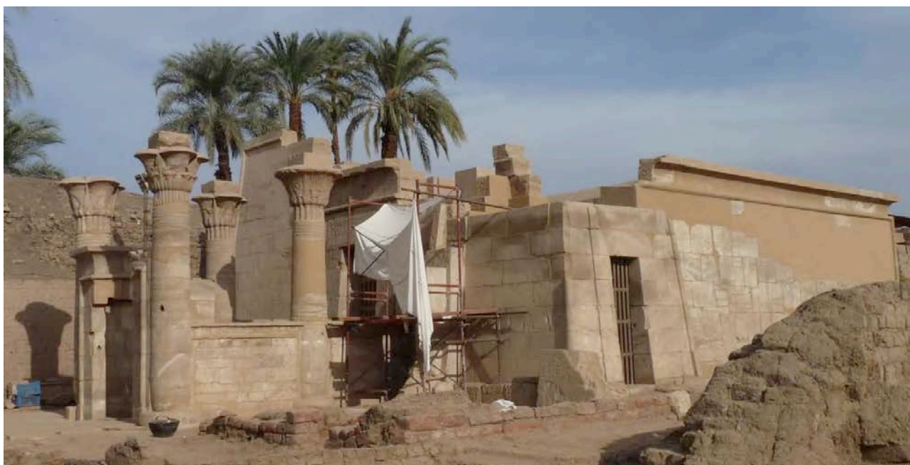
Figure 16. Vue générale après réalisation des enduits de finition © Cnrs-Cfeetk /L. Pieri.
