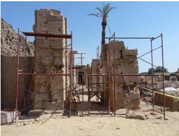
Figure 14. Porte A, élimination des anciens ragréages et ciment ©Cnrs-Cfeetk /L. Pieri
