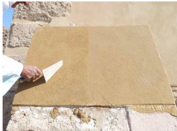
Figure 13. Enduit de finition raclé à la truelle à gauche ; frotté à l'éponge sèche à droite © Cnrs-Cfeetk /L. Pieri.
