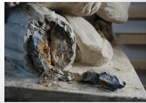
Suppression du plâtre et des fines tiges métalliques, éléments d'une ancienne réfection.
