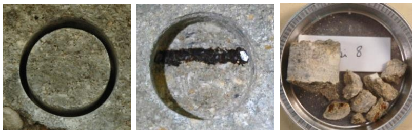
Figure 27 : Essais de percement du béton. ©INP/Brière.
