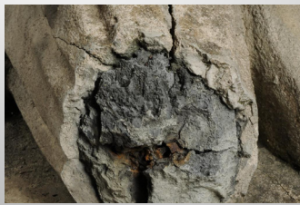
Corrosion des armatures métalliques © C. Brière
