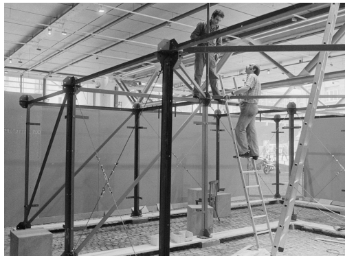
Fig. 3 Construction Du (ou de la) Poïpoïdrome Optimum au Centre Pompidou en 1978 pour l'exposition « Hommage aux Dogons et aux Rimbauds ».
