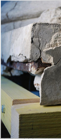
Armatures de la base, côté dextre, et dessous. © C. Brière
