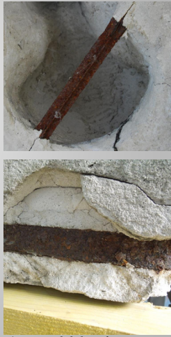
Armatures de la base, face arrière. © C. Brière
