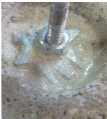
Figure 25 : Anode Galvostar® installée dans son mortier de scellement.
