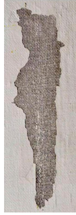
Après fixage des bords du film de peinture acrylique en soulèvement de la lacune
